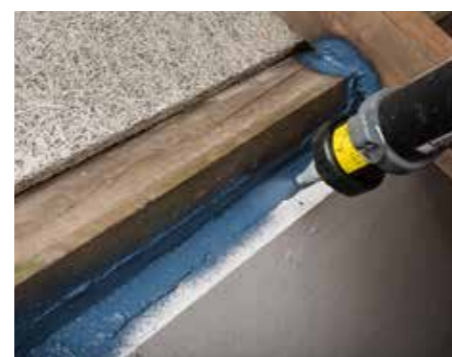
... in schwierigen Sanierungssituationen.
