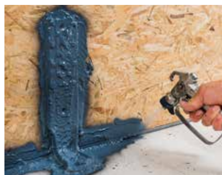
Luftdichtes Übersprühen von Befestigungswinkeln,
