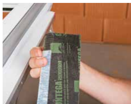
Trennfolienstreifen abziehen.
