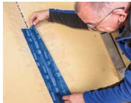
Klebeband kann direkt in frischen Primer verklebt werden.
