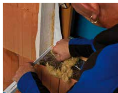
Fenster einsetzen und Fuge dämmen
