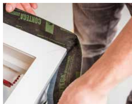
Eckschleife herstellen (Länge: 1,5 x Fugenbreite).
