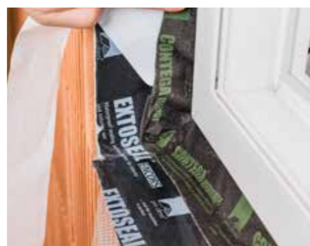
In Ecken luft- bzw. schlagregendicht verkleben.
