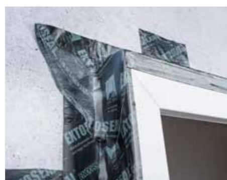
Anschluss von Fenstern im Mauerwerks- und Betonbau.
