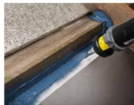
... in schwierigen Sanierungssituationen.
