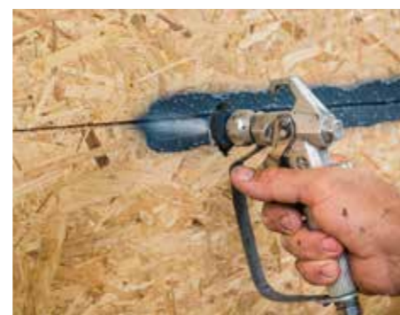
... Stößen zwischen Holzwerkstoffplatten,
