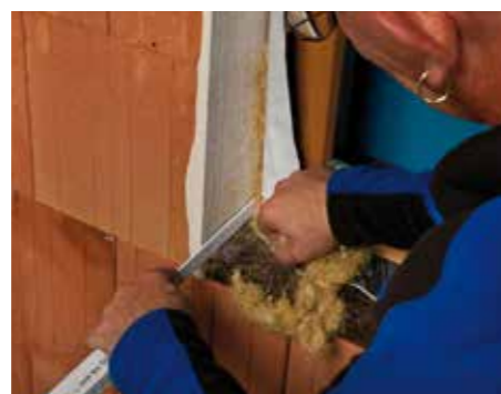
Fenster einsetzen und Fuge dämmen
