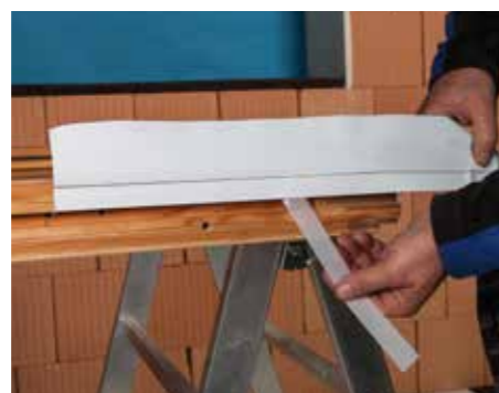
Seitlich am Blendrahmen verkleben
