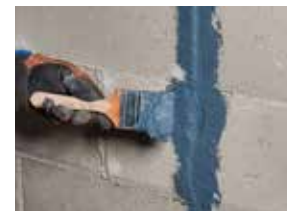
Zustreichen von Rissen bis 20 mm
