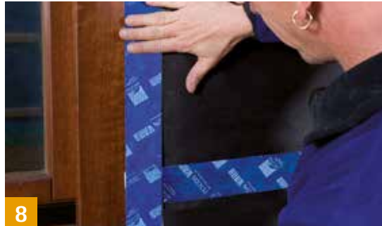
TESCO PROTECT Vorgefaltetes Winkelanschlussband
