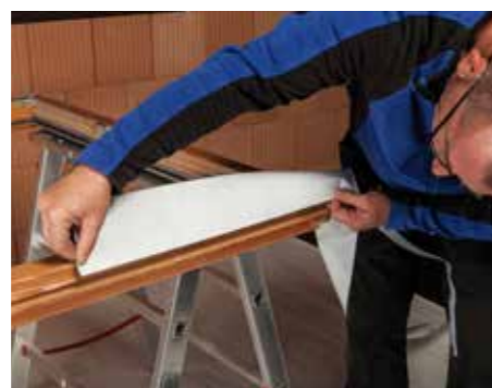
Seitlich am Blendrahmen verkleben
