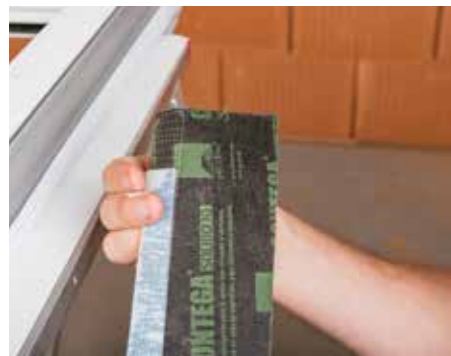
Trennfolienstreifen abziehen.
