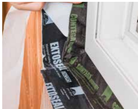
In Ecken luft- bzw. schlagregendicht verkleben.
