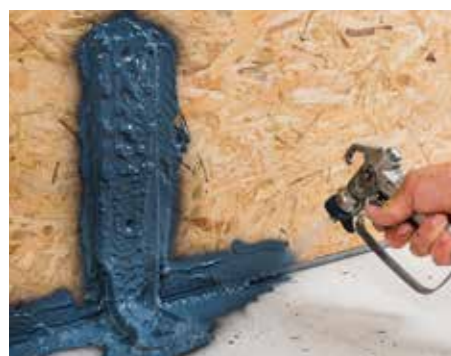
Luftdichtes Übersprühen von Befestigungswinkeln,
