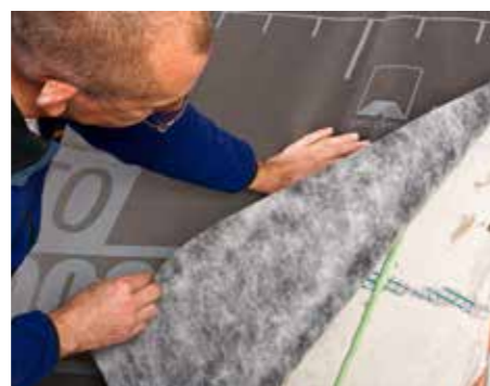
... Winddichtungsbahnen außen,
