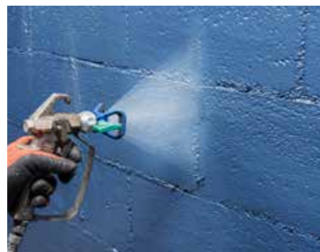
... unverputzten Wänden und
