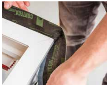
Eckschleife herstellen (Länge: 1,5 x Fugenbreite).
