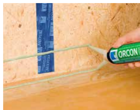
... und Bodenanschlüsse von Holzwerkstoffplatten,
